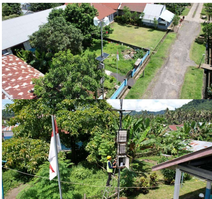
Gambar 20. Pemasangan Sirine EWS di Desa Sangaji Nyeku dan Lapangan Desa Duono
