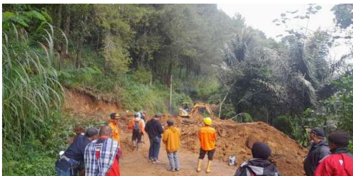
Gambar 8. Excavator sedang membersihkan material longsor yang menutup akses jalan desa
