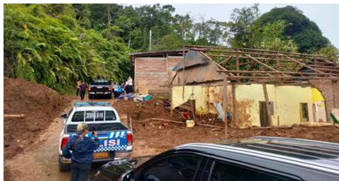
Gambar 16. Aparat melakukan pengecekan Lokasi terdampak tanah longsor
